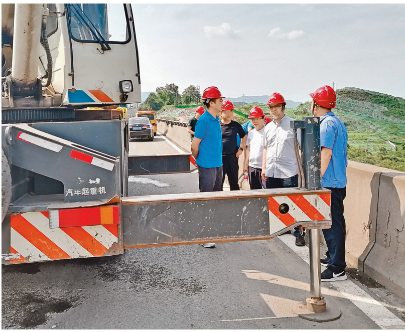
党委副书记、总经理熊戈亮现场调研管网工程建设。
