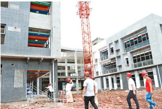
市纪委监委驻市教育局纪检监察组干部检查堰坝幼儿园工程建设情况
