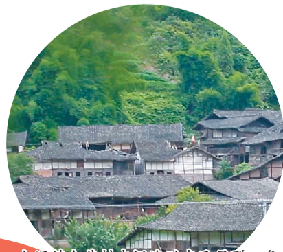
堰坝镇金黄村中坝沟川东民居群一角。
