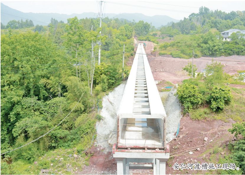
安仁河渡槽施工现场。
