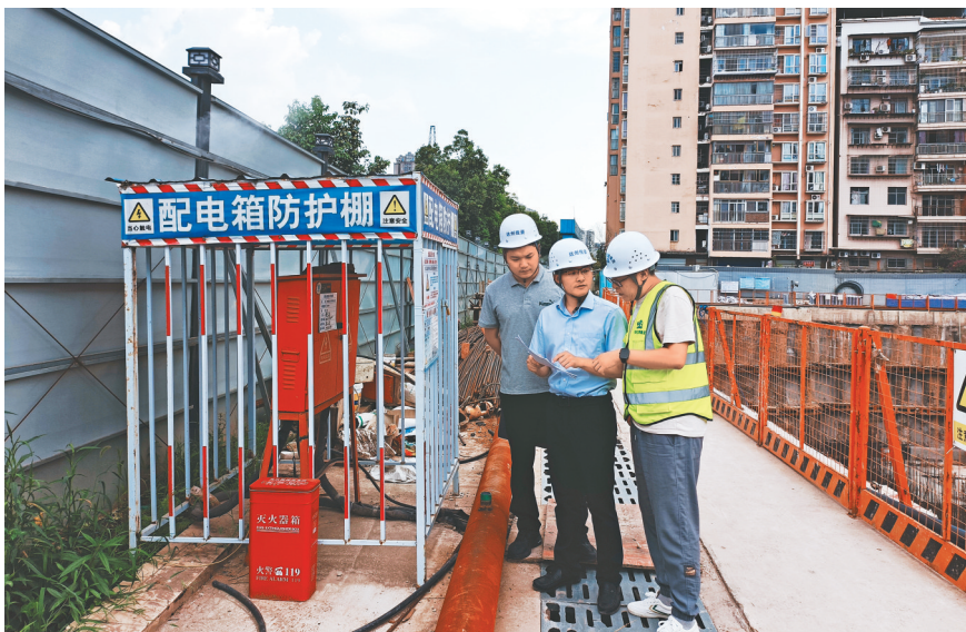
驻市投资公司纪检监察组在东部经开区项目现场检查安全生产。（吴晓 摄）
